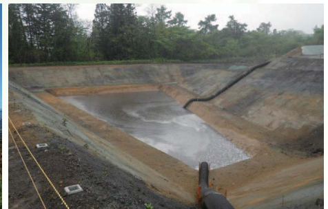
雨水対策のための調整池を整備
